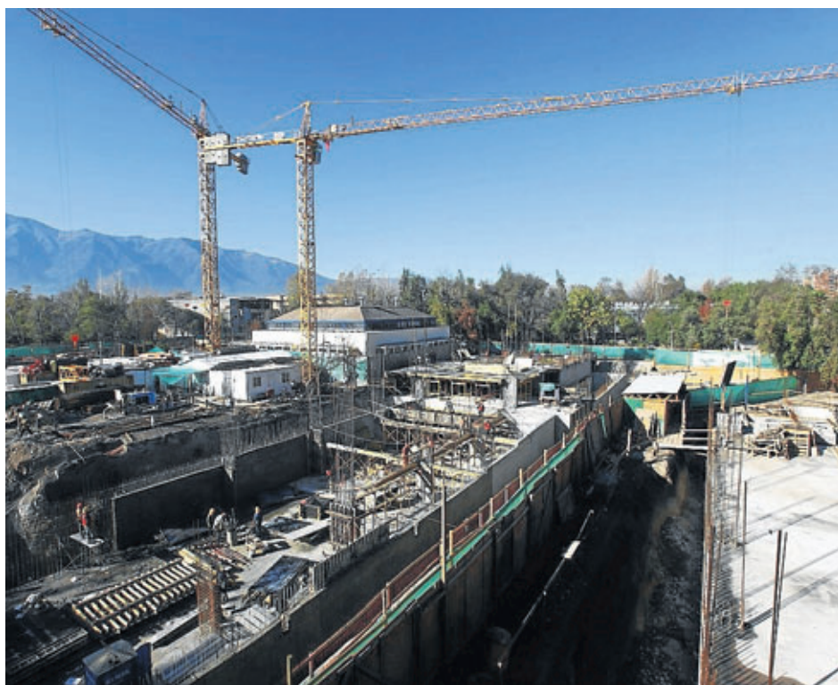
►► Un 45% de avance de la obra gruesa tienen dos de los aularios. FOTO: AGENCIAUNO
